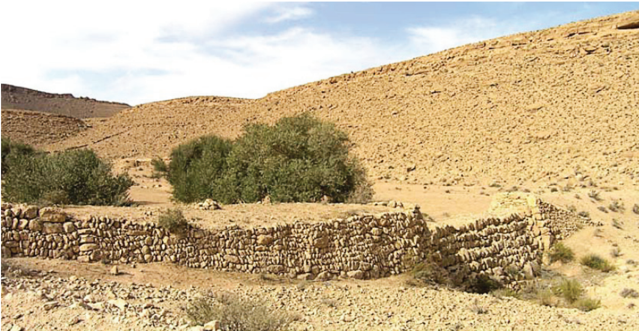
Figura 8.10 – Barragens de águas subterrâneas (a foto ilustra uma dessas represas no sul da Tunísia) são um meio eficiente de estocar a água em aquíferos superficiais. Essa técnica permite o uso da água em atividades de pastoreio extensivo e também de alguns tipos de culturas adaptadas ao clima árido. Reproduzido a partir da Fig. 7.5, página 339, UNEP/Geo-4 (2007).
