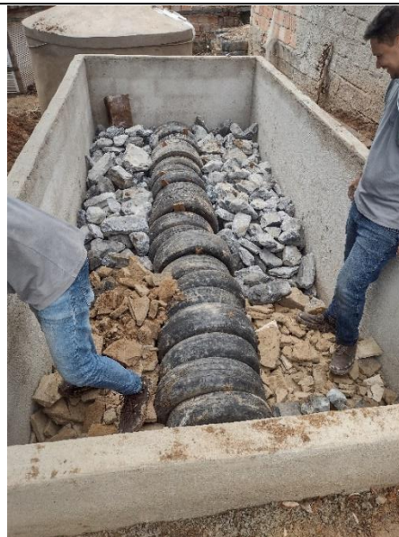
Foto 6 Instalação das TeVap e oficina demonstrativa Atividade 2.4.3
