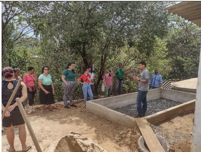
Foto 5 Instalação das TeVap e oficina demonstrativa Atividade 2.4.3.
