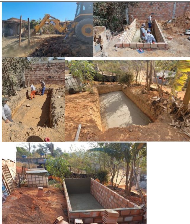
Foto 5 Instalação das TeVap – escavação com máquina e Processo construtivo alvenaria - Atividade 2.4.3
