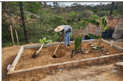
Foto 7 Instalação das TeVap – Aspecto final Plantio das bananeiras - Atividade 2.4.3
