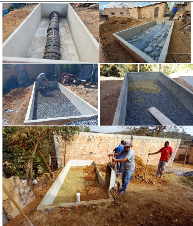
Foto 6 Instalação das TeVap – Processo construtivo Preenchimentos das TeVap - Atividade 2.4.3
