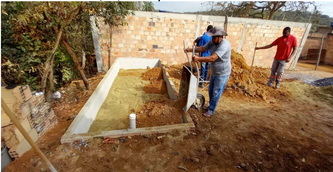
Foto 8 - Última camada (solo) sendo depositada na TEVAP.
