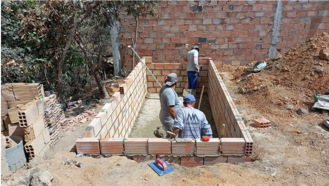
Foto 2 - Etapa construtiva da Alvenaria (TEVAP).
