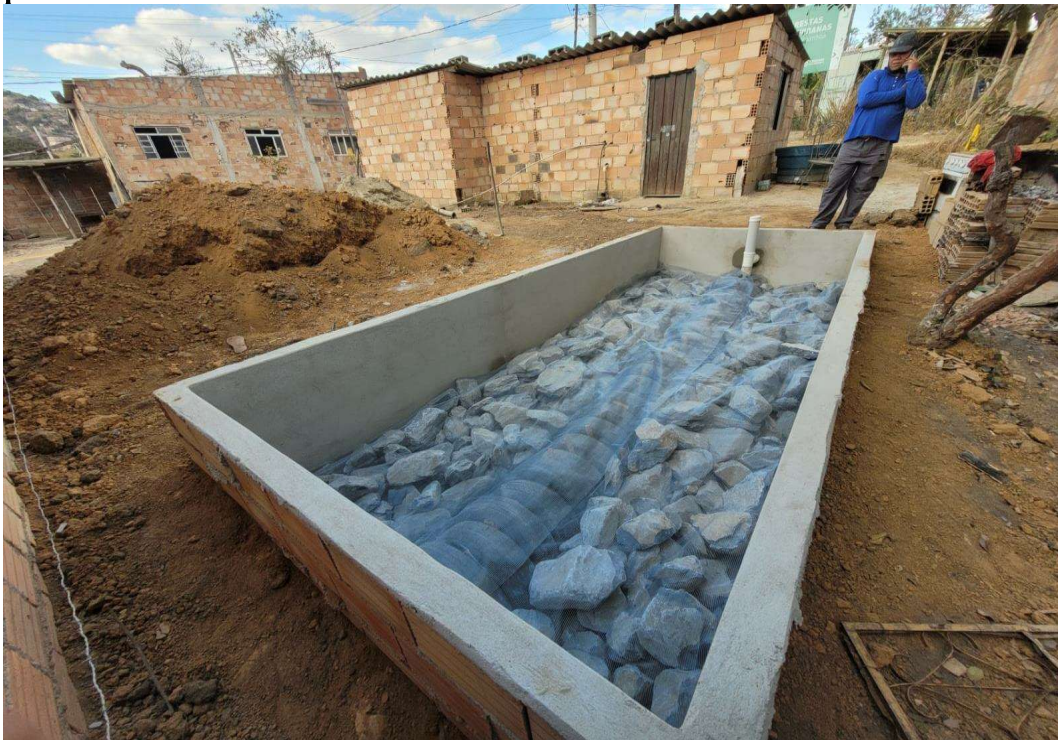
Foto 5 - TEVAP com a primeira camada de pedras de mão no nível da câmara de pneus e tela.
