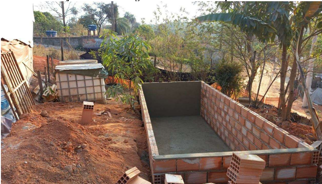
Foto 3 - TEVAP já com a concretagem de fundo e reboco parcial.
